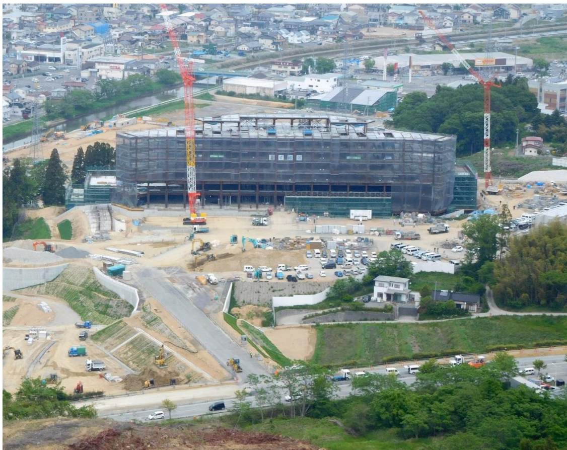
現場全景〔空撮・平成28年5月24日撮影〕
