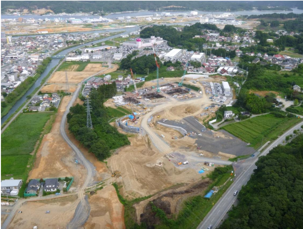
現場全景〔空撮・平成27年8月25日撮影〕
