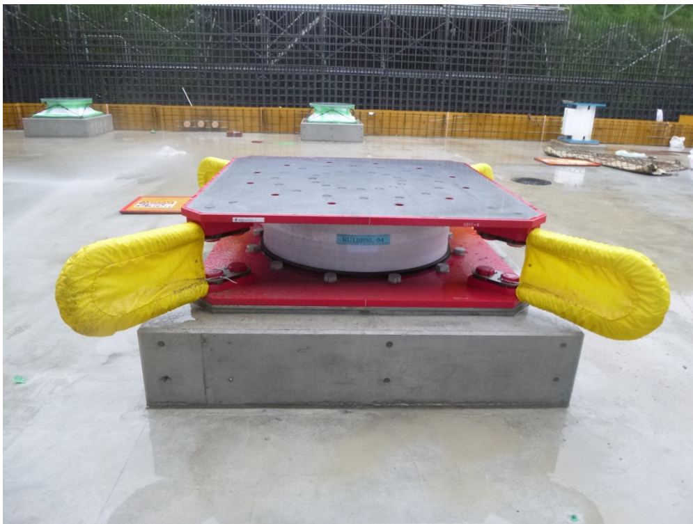
免震装置現地据え付け状況
